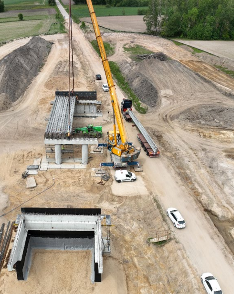
Fot. Elementy prefabrykowane, obiekt WD-56
