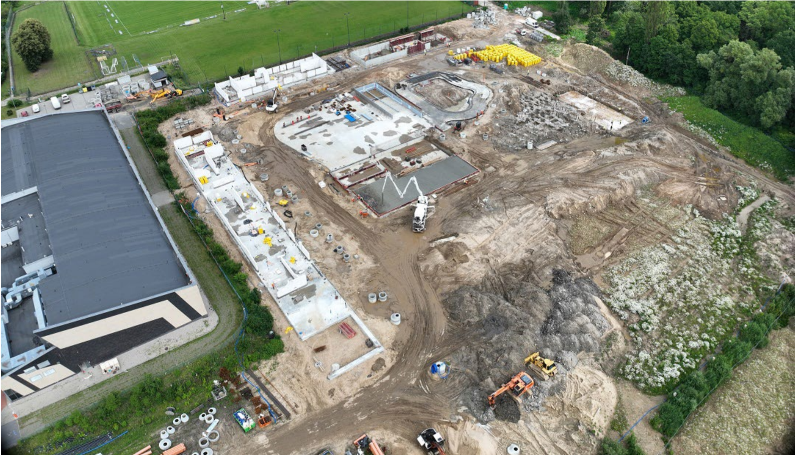
Fot. Widok na plac budowy kąpieliska
