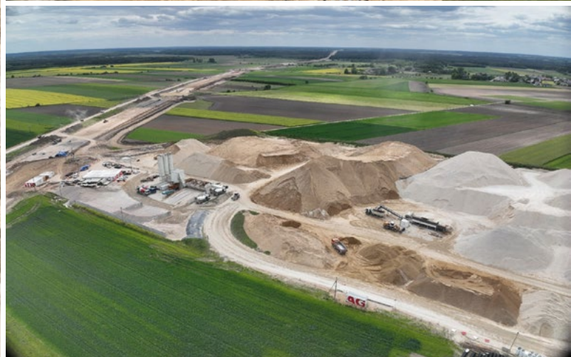
Fot. most nad rz. Nurzec (góra), węzeł betoniarski w Boćkach (dół)
