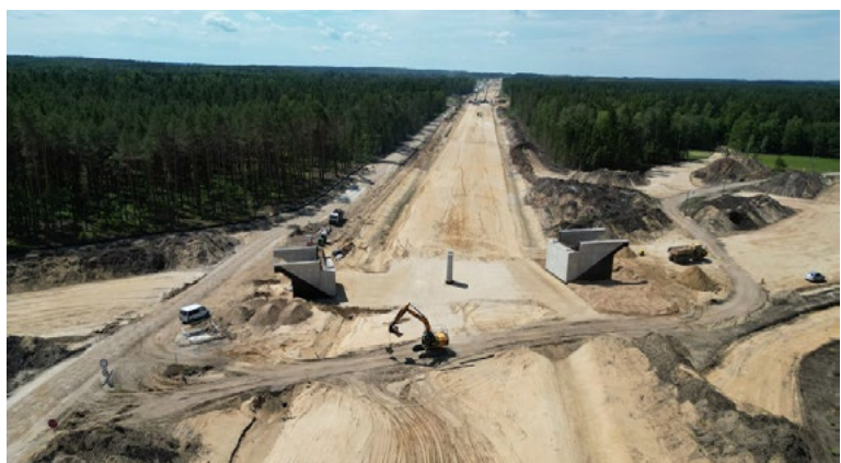
Fot. obiekt inżynierski WD-85
